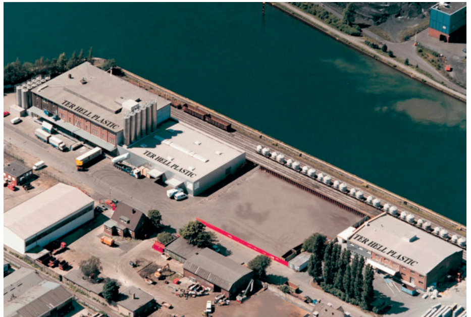
Bild 2. Das Produktions- und Logistikgelände nimmt eine große Fläche in Anspruch
